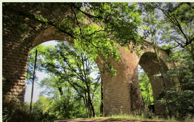
Viaduc de Sibillot à LAFAT
