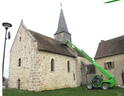
Une fuite importante dans la toiture de l'église a permis de déceler une anomalie au niveau de la charpente entraînant un affaissement de celle-ci.
