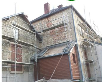
L'entreprise Aussourd met les bouchées doubles car le ravalement des pignons et façade arrière de la mairie a débuté avec un peu de retard en raison de la météo défavorable au printemps. Cette réfection de l'enduit permettra à l'immeuble de retrouver une protection efficace. Il subissait des dommages en raison de l'humidité et présentait des risques pour les usagers.
