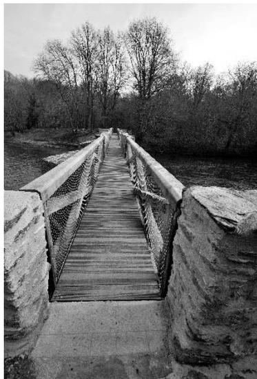
Les piles et culées en elles-mêmes ont été solidifiées par des tirants (tiges métalliques ancrées de part et d'autre), les vides intérieurs ont été comblés par du béton, les joints ont été repris après nettoyage. Les parapets et
